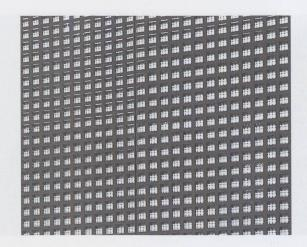
Per il loro comportamento prestazionale, sopra tutto i rivestimenti metallici degli edifici sono chiamati a garantire risposte di accessibilità, ispezionabilità, sostituibilità e pulibilità. Tra le cause, i raggi UV e l'inquinamento atmosferico particolarmente evidenti sulle termolaccature di colore scuro (blu Klein per lo stabile esaminato).
