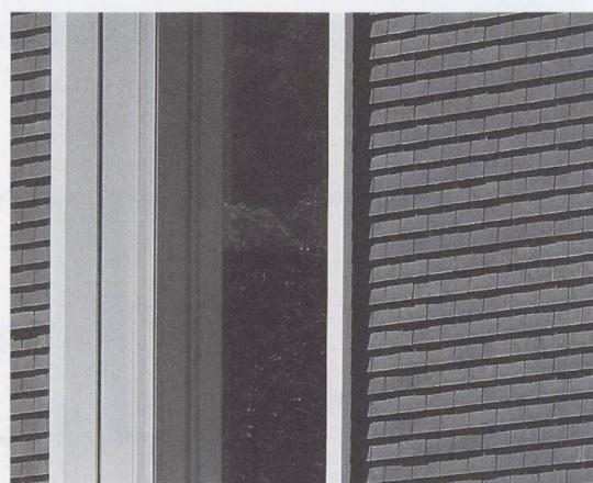
e la qualità nel tempo del prodotto edilizio sono mantenuti attraverso l'osservanza delle prescrizioni di posa – facili, ma essenziali – del fabbricante. Al pari di altri rivestimenti, la facciata esterna necessita dello strato di ventilazione costituito da una camera d'aria connessa con l'ambiente esterno.
