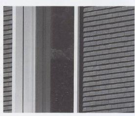
e la qualità nel tempo del prodotto edilizio sono mantenuti attraverso l'osservanza delle prescrizioni di posa – facili, ma essenziali – del fabbricante. Al pari di altri rivestimenti, la facciata esterna necessita dello strato di ventilazione costituito da una camera d'aria connessa con l'ambiente esterno.
