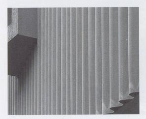
L'intero sistema costruttivo è stato applicato su una costruzione artigianale esistente. Il principio scelto di copertura delle facciate ha reso omogeneo l'intero immobile rendendo indefinibile la separazione tra nuovo ed esistente. In questo caso, il sistema di facciata ventilata ha risolto la difficile interconnessione tra gli aspetti tecnico-costruttivi e quelli concernenti il funzionamento energetico dell'involucro.
