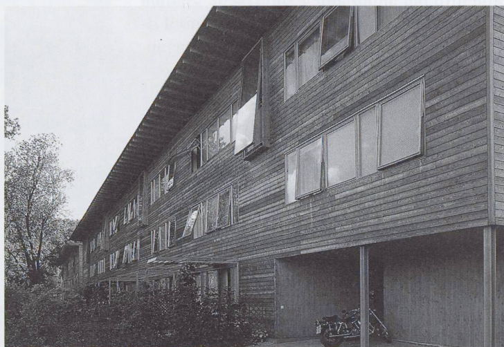
Rivestimento in legno con tavole orizzontali di edificio abitativo a tre piani. Trofaiach, Stiria, Austria. (Foto proHolz Austria, Martinez)
