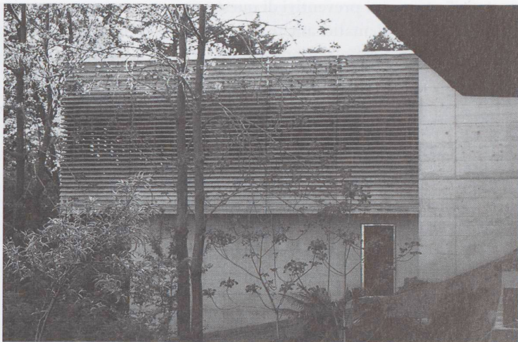
Involucro in lamelle di legno di castagno ad inclinazione variabile in funzione dell'altezza. Parcheggio pubblico Orselina
