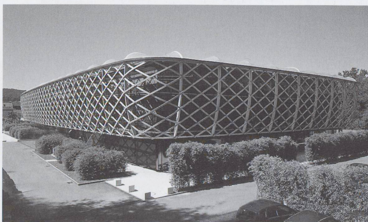
Un esempio di involucro in legno particolare e senza funzioni protettive: Stabile Hugo Boss, Coldrerio. (Foto H. Ege, Lucerna / Lignum)
