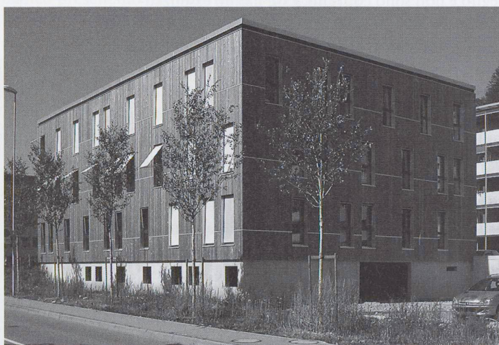
Facciata in legno abete bianco, trattata e ingrigita prima della posa. «Green Offices», Freiburg-Givisiez. (Foto: M. Meuter, Zurigo / Lignum)
