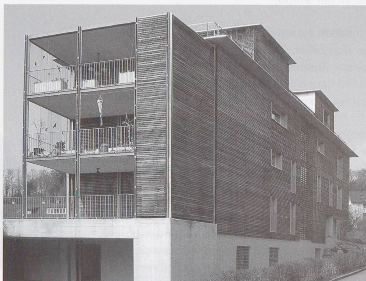
Rivestimento in legno non trattato. (Foto Lignum Zurigo)
