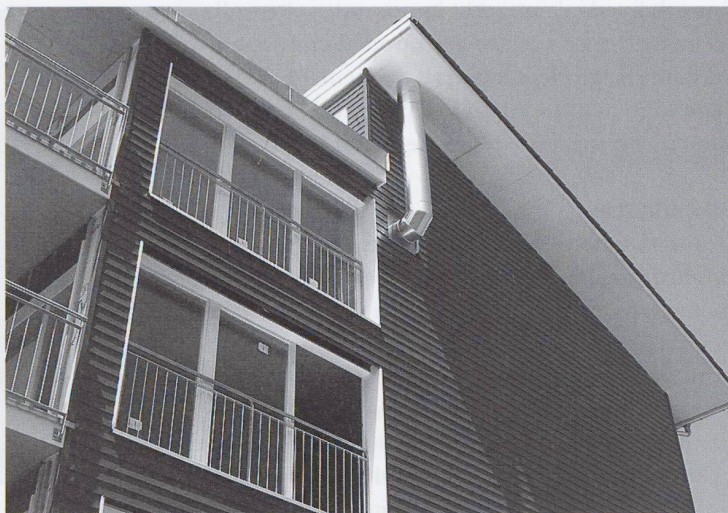
Facciata in legno con trattamento coprente. (Foto: Lignum Zurigo)
