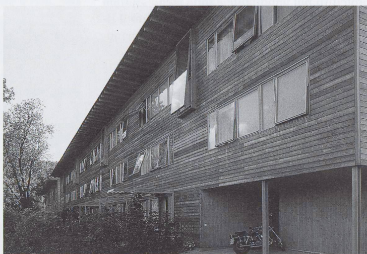
Rivestimento in legno con tavole orizzontali di edificio abitativo a tre piani. Trofaiach, Stiria, Austria. (Foto proHolz Austria, Martinez)
