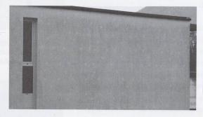
Fig. 6 e 7 – Patina biologica su una facciata rivestita con un sistema termoisolante a cappotto. I giunti dei pannelli termoisolanti e i loro fissaggi puntiformi agiscono come ponti termici, accelerando così localmente l'essiccamento dell'intonaco. La ridotta disponibilità di acqua previene lo sviluppo dei microrganismi
