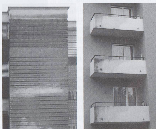
Fig. 3 – Patina biologica su una facciata in calcestruzzo facciavista a seguito di una superficie fortemente strutturata orizzontalmente
