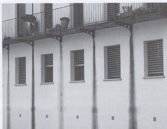
Fig. 2 – Striature verticali scure formate da colonie di microrganismi, il cui sviluppo è dovuto a colature di acqua piovana sulla facciata in corrispondenza degli appoggi del terrazzo
