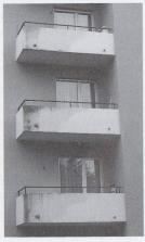
Fig. 3 – Patina biologica su una facciata in calcestruzzo facciavista a seguito di una superficie fortemente strutturata orizzontalmente Fig. 4 – Crescita di alghe sui parapetti dei balconi a seguito di problemi di allontanamento dell'acqua piovana
