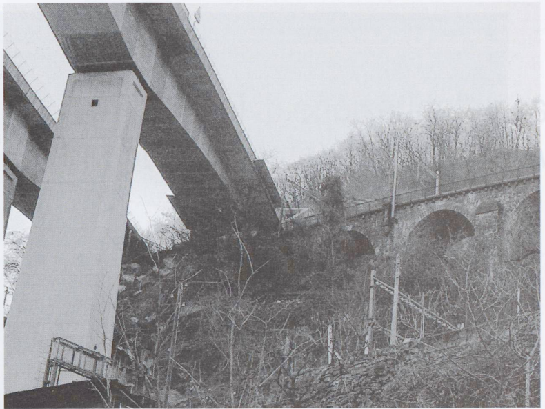
Fig. 4 – Materiali e opere del XIX e XX secolo a confronto in Leventina. Dall'utilizzo prevalente di pietra naturale e acciaio della strada ferrata al calcestruzzo precompresso dell'autostrada. Testimonianze importanti, rivolte al futuro, del nostro passato.
