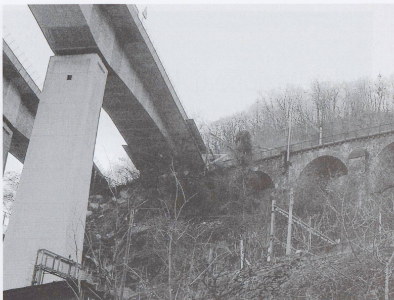
Fig. 4 – Materiali e opere del XIX e XX secolo a confronto in Leventina. Dall'utilizzo prevalente di pietra naturale e acciaio della strada ferrata al calcestruzzo precompresso dell'autostrada. Testimonianze importanti, rivolte al futuro, del nostro passato.
