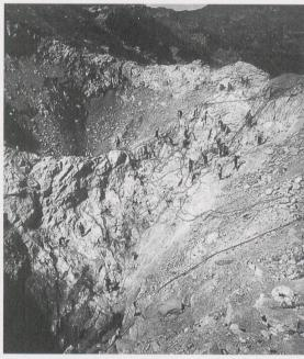
Fig. 3 – Centrale di Goglio. Lo scavo per la condotta forzata, 1936 Fig. 4 – Diga di Morasco. Cava di pietrame, 1938 (Immagini tratte da *Girola – un'impresa sulle Alpi*, 1997, Edizioni Verlag Scheidegger & Spiess AG).
