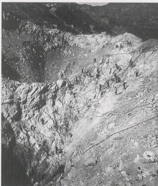
Fig. 3 – Centrale di Goglio. Lo scavo per la condotta forzata, 1936
