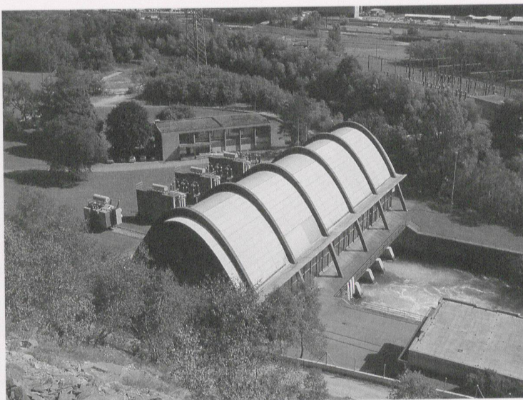
Fig. 5 – La centrale nuova Biaschina: l'impianto venne costruito dal 1962 al 1967 e ampliato nel 1974. Esso sfrutta il dislivello che il fiume Ticino ha da Lavorgo fino a Personico (quota 302 m.s.m.)
