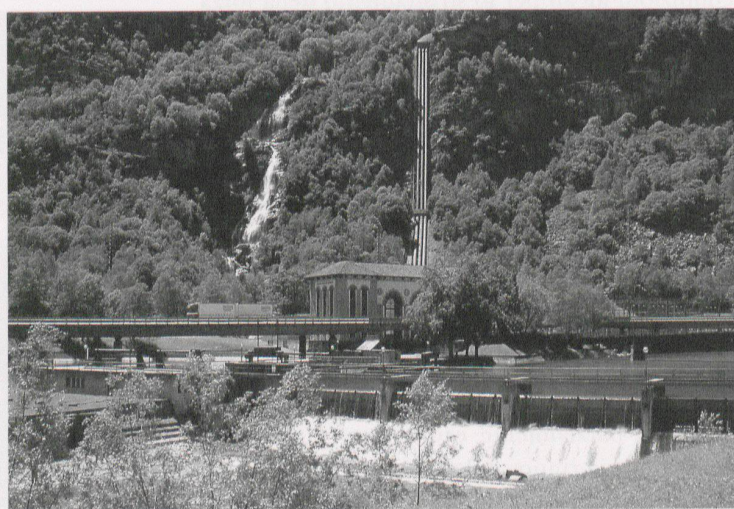
Fig. 4 – La centrale Piottino: sfrutta il fiume Ticino e gli affluenti della sponda destra da Rodi a Lavorgo. L'impianto venne costruito dal 1928 al 1932. Nel 1940 è stato costruito un bacino di compenso a Rodi, nel 1942 l'immissione del torrente Piumogna
