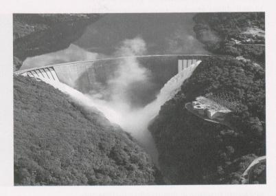
Fig. 1 – L'impianto idroelettrico ad accumulazione della Verzasca: utilizza le acque del bacino imbrifero della Valle Verzasca. Una diga alta 220 m, una fra le più alte in Svizzera, sbarra la valle, formando un bacino di accumulazione con un invaso totale di 105 milioni di metri cubi
