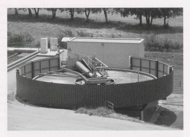
Supercell (impianto a flottazione tradizionale) sviluppato da Krofta Water International (KWI). L'impianto in questione è in funzione dal 2000 alla stazione regionale di depurazione di Visp. Quattro minuti sono sufficienti per depurare 56 m³ di acque reflue contenute in un bacino di una profondità di soli 40 cm (Photo Lonza AG)
