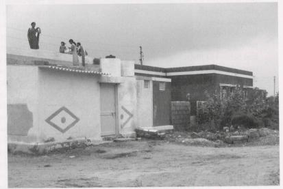
Fig. 1 – Produzione di mattoni di argilla cotta, distretto di Kutch, Gujarat, India, 2008 Fig. 2 – Case costruite dopo il terremoto del 2001 con murature a base di terra stabilizzata, distretto di Kutch, Gujarat, India, 2007
