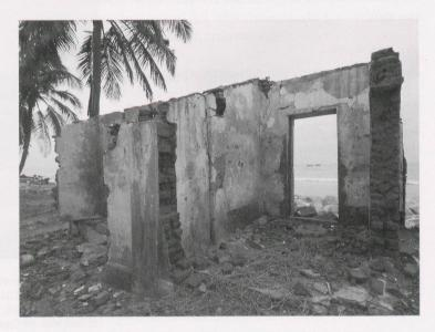
Fig. 1 – Casa distrutta dallo tsunami del 26 Dicembre 2004, stato del Tamil Nadu, India (foto D. Pittet)
