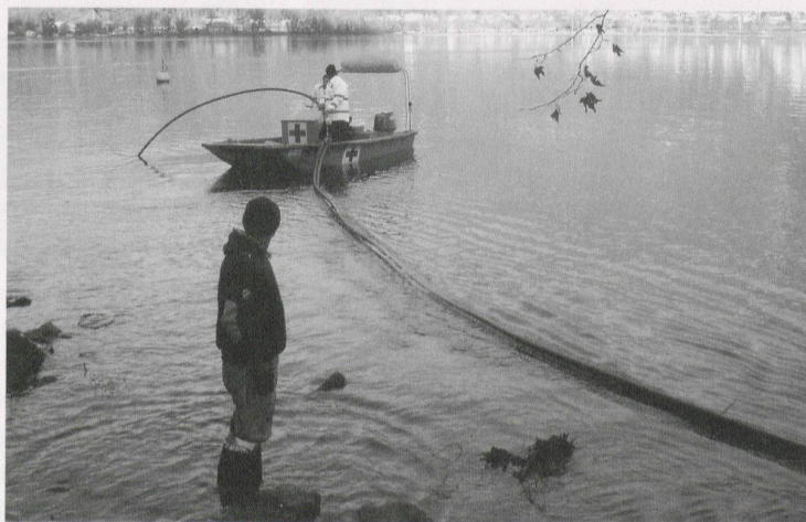
Fig. 5 – Posa delle tubazioni nella zona di prelievo dell'acqua a Riva San Vitale per l'analisi preliminare su più mesi.
