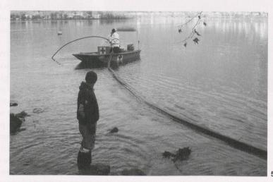
Fig. 5 – Posa delle tubazioni nella zona di prelievo dell'acqua a Riva San Vitale per l'analisi preliminare su più mesi.
