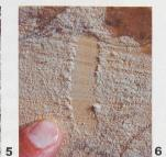
Fig. 7 – Dettaglio della superficie dello stucco con le efflorescenze di nitronatrite.
