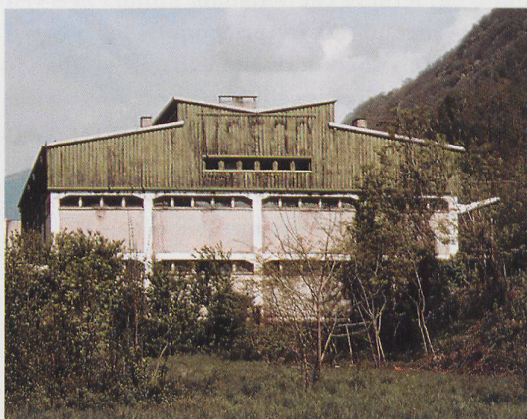
Bironico, magazzini USEGO – demolizione di un'opera chiave
