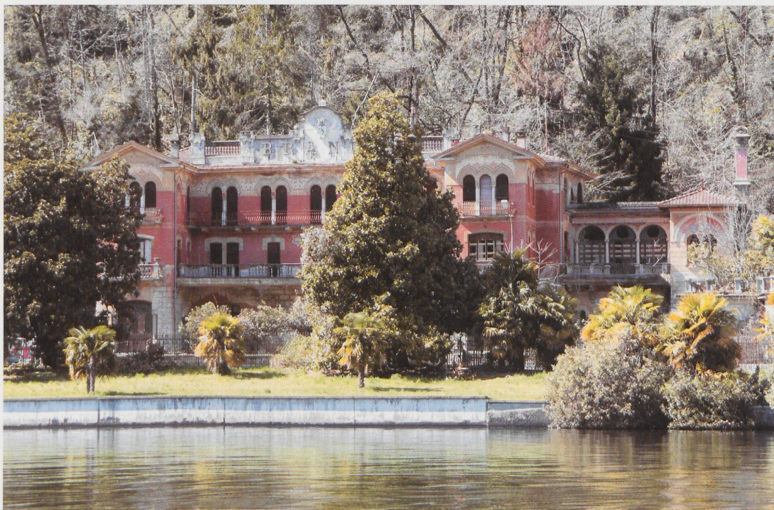
Melide, Villa Branca – una distruzione incomprensibile
