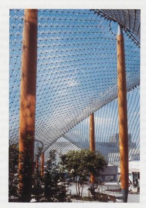
Fig. 4 – Copertura a struttura reticolare in cavi a Bad Neustadt e rivestimento con assicelle in vetro.
