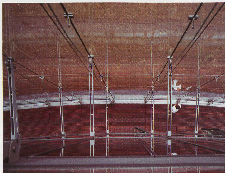
Fig. 8 – Facciata vetrata a cavi paralleli con vetri isolanti alla sede Bayer di Levenkusen
