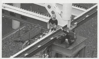
compressione delle colonne. Le tolleranze in lunghezza sono state considerate mediante lastre di rivestimento in corrispondenza dei giunti ad alta resistenza precaricati e fori longitudinali in corrispondenza dei raccordi articolati.
