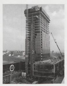
Considerando lo schema di deformazione è stata prevista una sopraelevazione a nodi della struttura portante.
