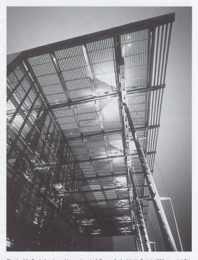
Fig. 1 – Mt. Cenis Academy, Herne, Jourda & Perraudin Architetti, Parigi, 1999. I moduli FV sono parte integrante dell'involucro dell'edificio e partecipano in modo rilevante all'espressione architettonica
