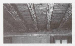
Spesso dissesti locali si nascondono sotto ai controsoffitti e sfuggono a dei semplici controlli puntuali, è quindi sempre raccomandabile una verifica completa, soprattutto se l'età o lo stato della costruzione possono fare supporre che gli elementi strutturali siano deteriorati o se l'edificio ha subito diversi interventi nel tempo.
