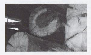
Travi di legno: quella di mezzo ha la sezione interna completamente marcita a causa dell'umidità, quella di destra è sezionata in due da spaccature longitudinali.
