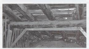
Nell'esempio illustrato dalla fotografia la puntellazione inadeguata di una trave, la cui sezione è stata indebolita da infiltrazioni di acqua, è poco efficace e destinata a rompersi al momento che la trave sostenuta cede; inoltre è causa di spinte orizzontali non desiderate sulla struttura sottostante. In casi del genere spesso l'unica soluzione è la sostituzione di parte degli elementi portanti o dell'intera struttura.
