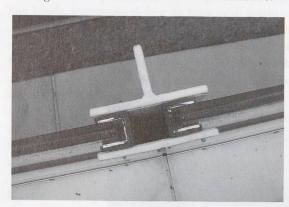
Le pareti vetrate sono in parte posizionate a quota superiore di zone abitate e sopra la carreggiata autostradale Nord-Sud. Per assicurare i vetri contro la caduta a seguito di eventuali impatti, l'installazione delle lastre vetrate prevede un sistema di ritenuta di sicurezza mediante il loro ancoraggio a piccole corde in acciaio inossidabile fissate alla struttura portante.
