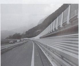
La struttura vetrata è stata sviluppata nell'ottica della migliore sicurezza, verificata con tests alla rottura su campioni appositamente costruiti in scala reale.
