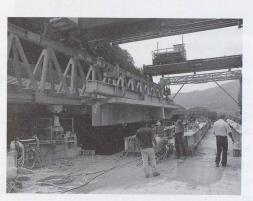
Fig. 5 – Rimozione delle travi intermedie
