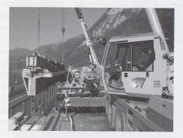
Fig. 4 – Rimozione delle travi di bordo
