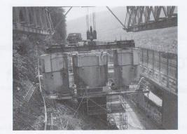
Fig. 6 – Rimozione delle travi trasversali e di testa pila (pulvini)
