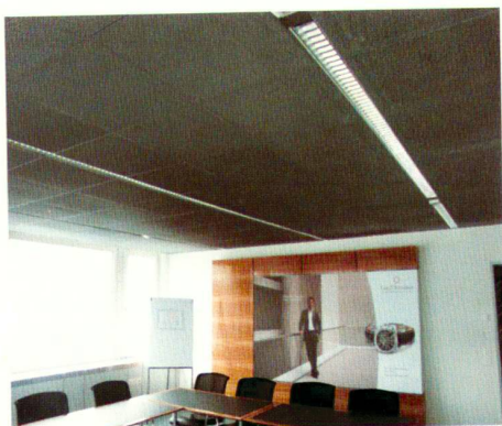
Soffitto in lamiera stirata
