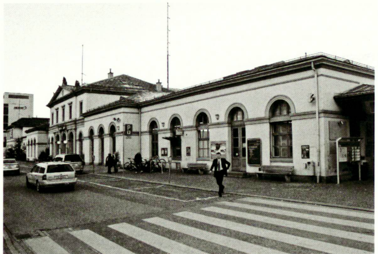
La stazione attuale
