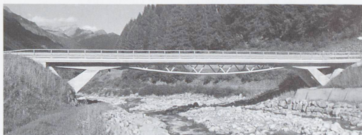
Ponte sul Ticino a Villa Bedretto, progetto A. Muttoni (Grignoli Muttoni partner), esecuzione 1996-97, lunghezza 44.00 m
