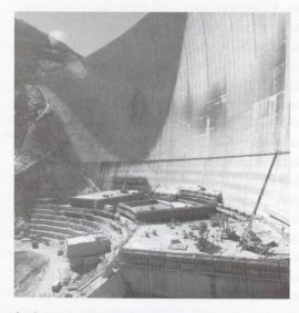
8 – Costruzione del massiccio d'appoggio nella diga di Koelbrein (Austria)
