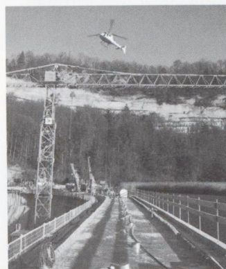
14 - Lavori di risanamento alla diga di Maigrauge (Svizzera)
