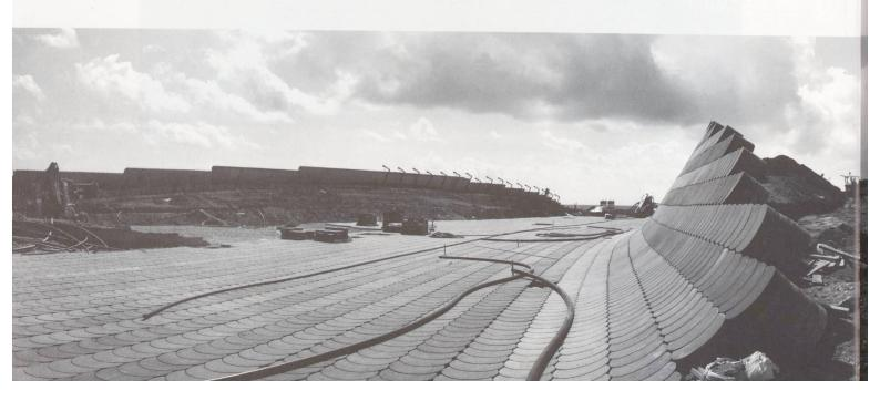
permettere il deflusso delle acque meteoriche. Con lo stesso tassello è possibile realizzare pavimentazioni di superfici a curvatura variabile; con la sua forma risolve i seguenti temi: pavimentare con la massima aderenza possibile tra i singoli corsi e realizzare un disegno continuo anche in presenza di curve sia sul piano orizzonta-
