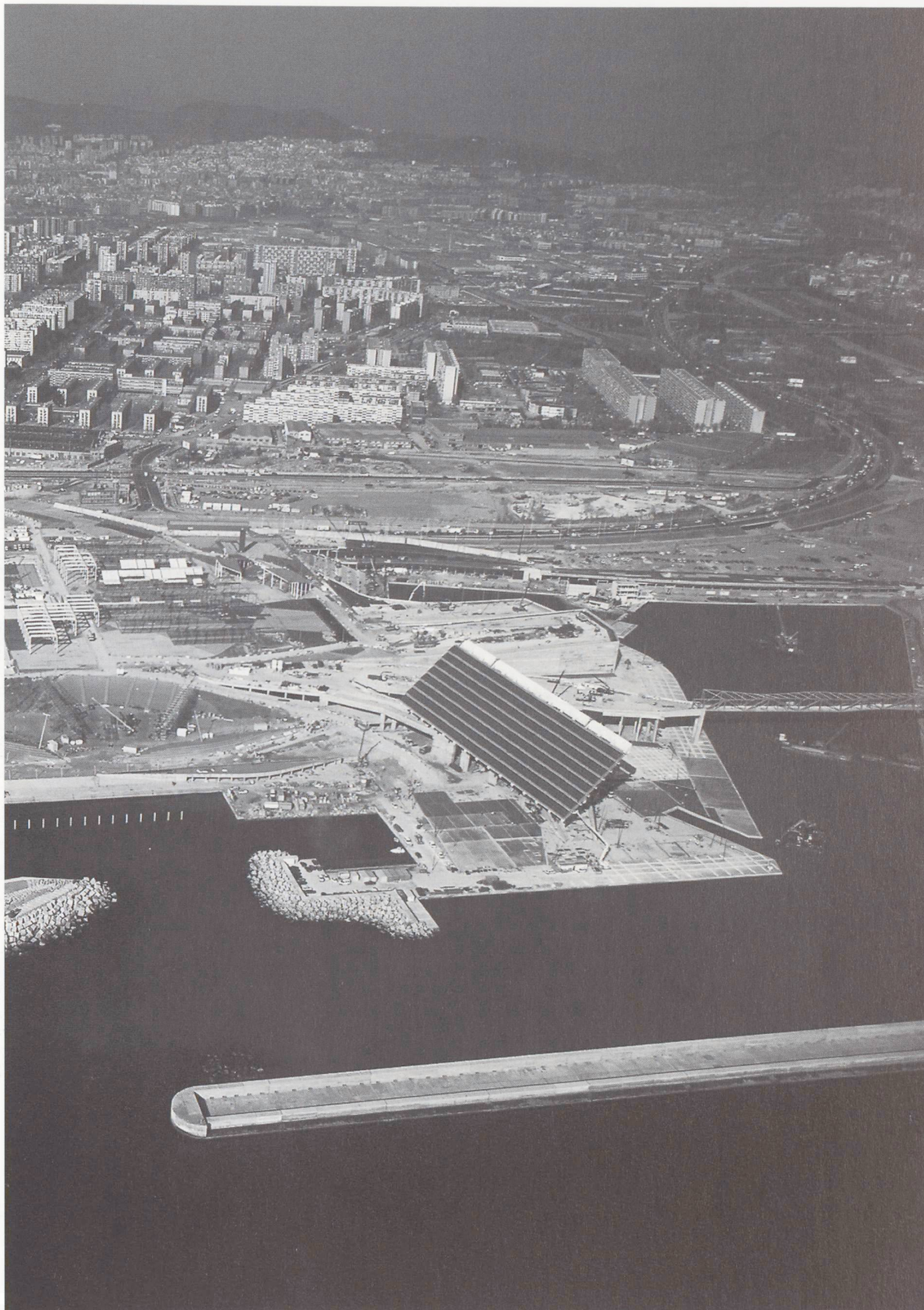
Fotografia aerea della piazza con la grande pergola fotovoltaica
