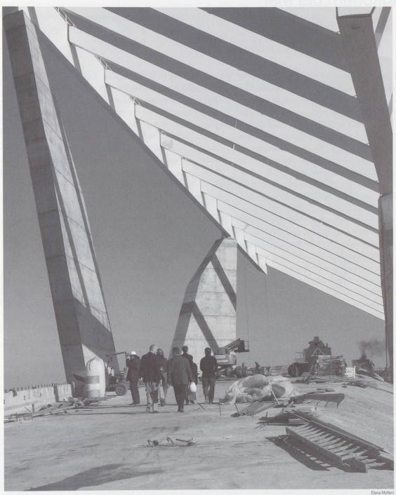
Immagine della grande struttura della pergola; un piano inclinato con un'altezza massima di 55 metri e un area di 4'800 m².
