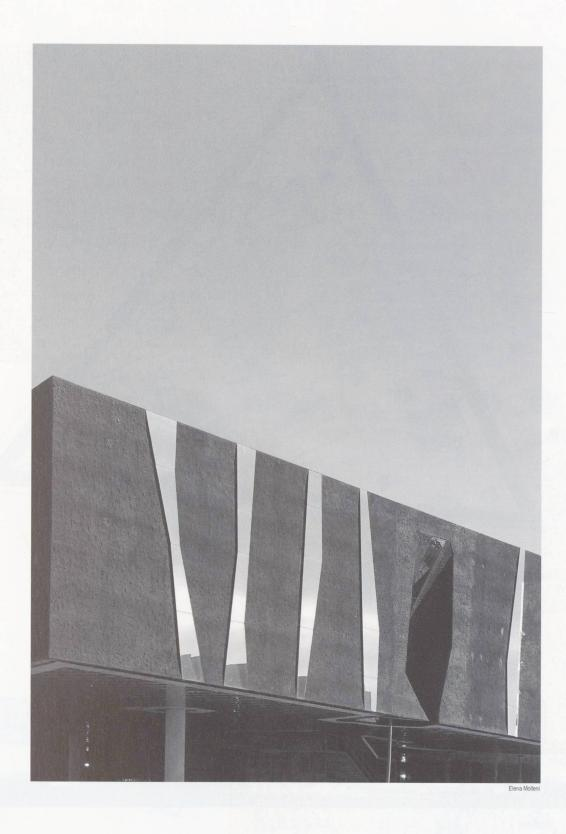
Particolare del fronte. Da notare il contrasto tra i materiali: la superficie brillante e riflettente delle strisce vetrate che collegano il volume al cielo, l'ombra scura dell'anfratto, la rugosità della pelle-muratura e la natura metallica e riflettente del rivestimento della parte sottostante.
