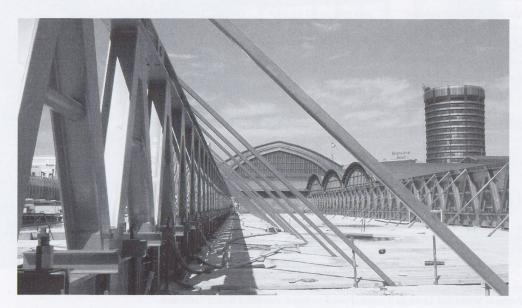
$2-\mbox{\sc Vista}$  superiore del  $\,$  ponte a cassone con i due tralicci di acciaio di rinforzo temporanei
