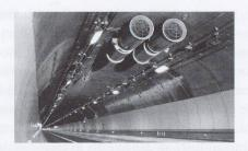
10 - Sistema di ventilazione longitudinale con jet fans
