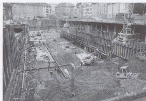
7 - Cantiere «Titanic II»
