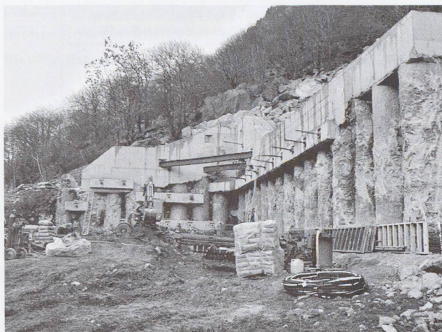
18 – Vista equivalente a metà scavo. Sulla destra c'è la parete di sostegno divisoria tra le canne ovest e est. È in perforazione e posa il secondo livello d'ancoraggio
