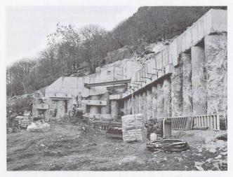
18 – Vista equivalente a metà scavo. Sulla destra c'è la parete di sostegno divisoria tra le canne ovest e est. È in perforazione e posa il secondo livello d'ancoraggio
