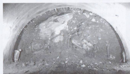
Fronte di scavo in materiale sciolto
