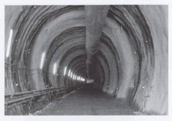
Galleria in materiale sciolto, tubo ovest. Da notare la sagoma «a dente di sega», tipica degli avanzamenti a infilaggi
