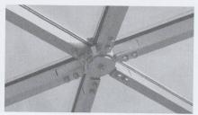
di cavi con diametro di 14 e 20 mm pretesi e disposti a raggiera.
