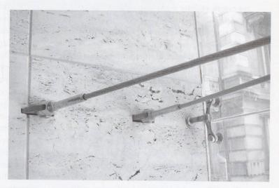
16 - Dettaglio ancoraggi cavi nella struttura principale
