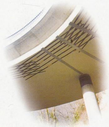
Il rinforzo dell'armatura di frettaggio delle pile è stato realizzato con tessuto in fibre di carbonio **SikaWrap**.
