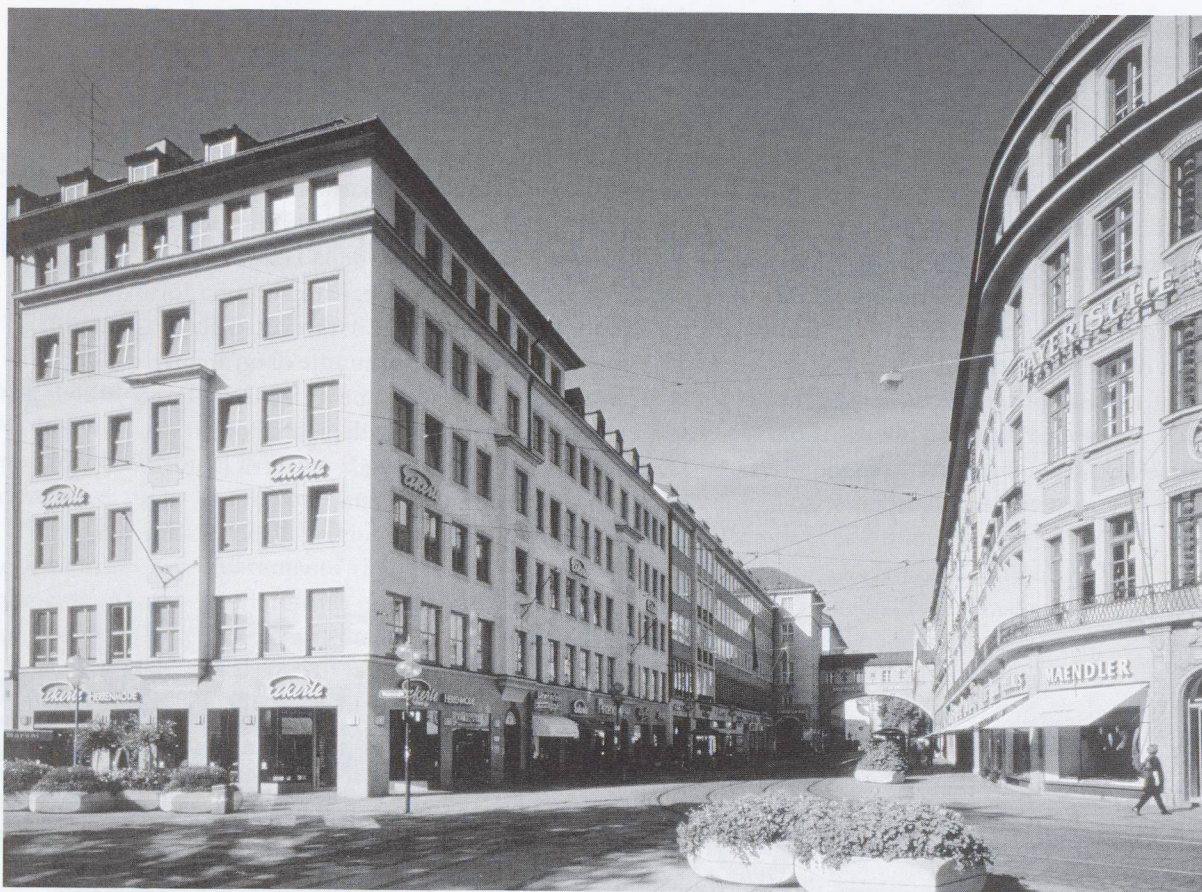
Situazione prima dell'intervento, angolo Weinstrasse - Maffeistrasse
