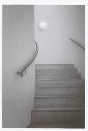
9 – La scala attorno alla parete curva dell'ascensore. Il corrimano è un tubo di acciaio inossidabile a sezione circolare, l'unico materiale dichiaratamente moderno e non di colore bianco utilizzato all'interno dell'edificio.
