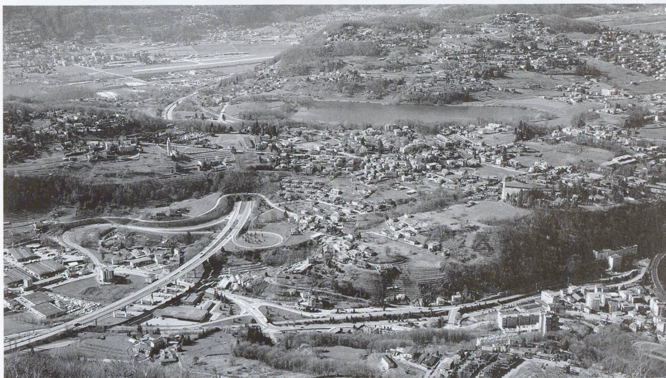
La regione di Lugano con la nuova infrastruttura di autostrade.
