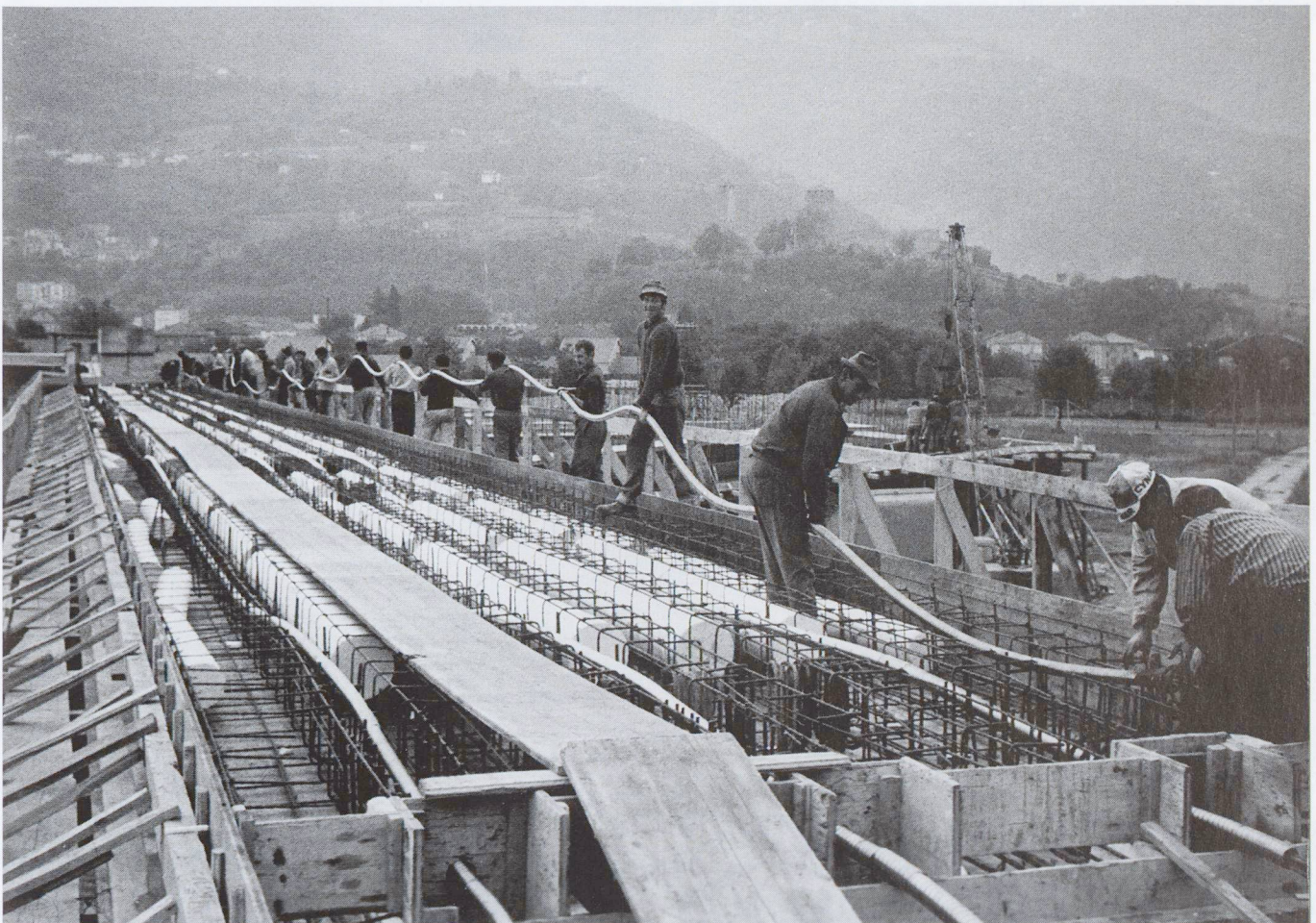
Foto di cantiere, 1968
