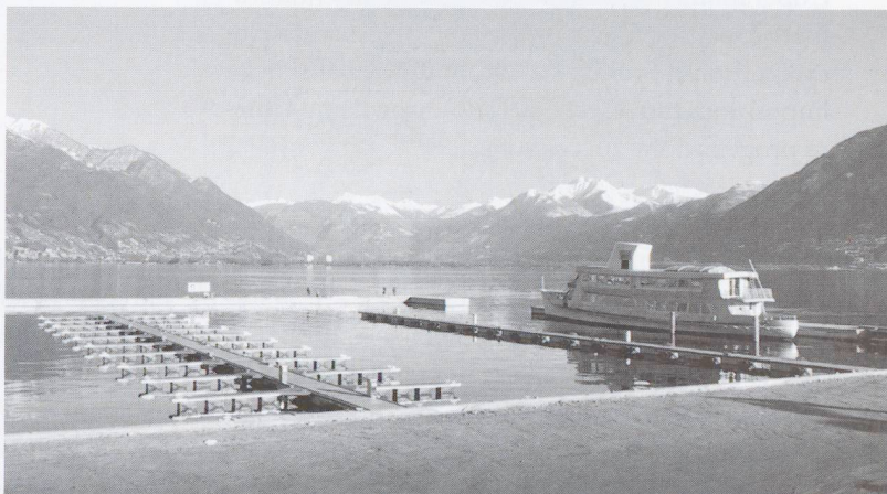
Imbocco sud e battello-ristorante capitaneria
