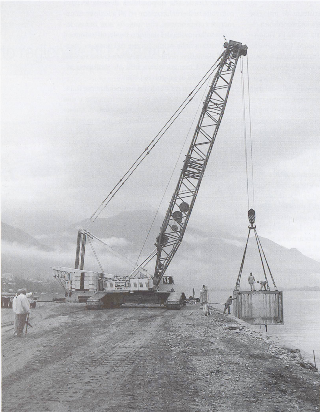
Varo di un elemento del molo frangionda
