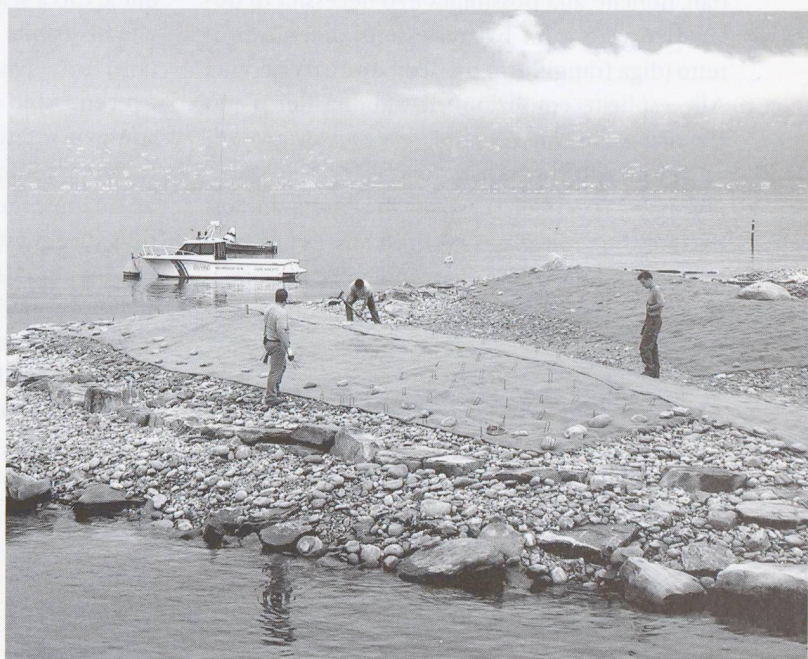
Interventi di recupero paesaggistico
