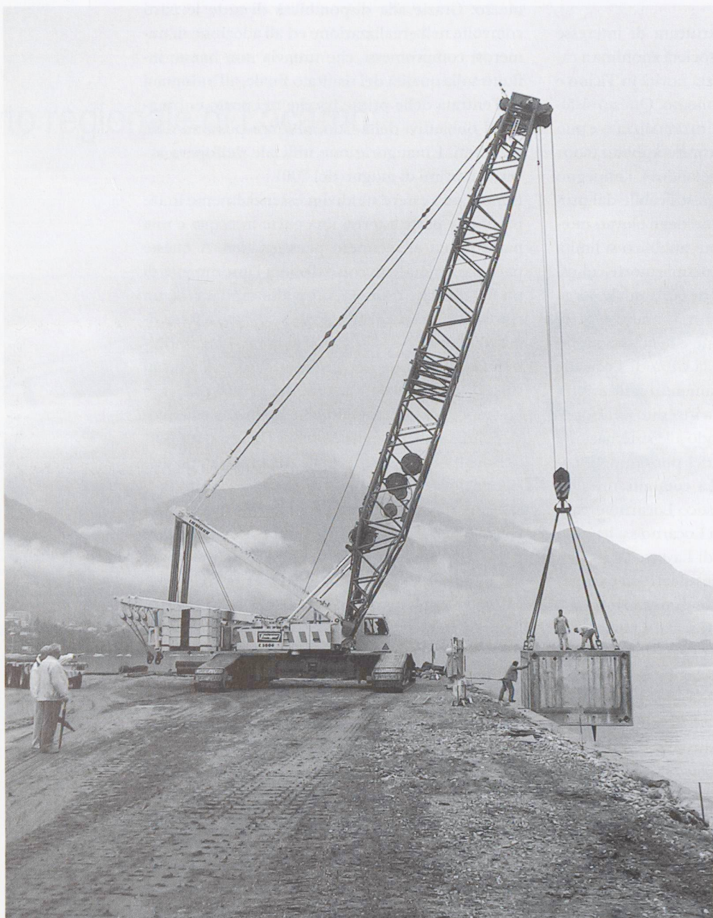
Varo di un elemento del molo frangionda
