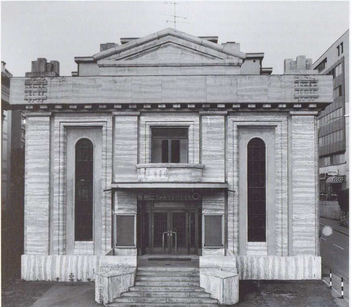
Fronte principale del Cinema-Teatro di Chiasso dell'arch. A. Marazzi, 1935 (di recente, oggetto di un ripristino)
