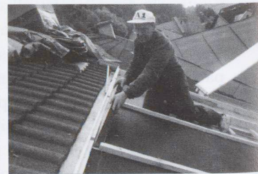
Montaggio di un pannello isolante
