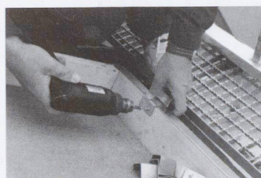
Montaggio dei supporti per il vetro
