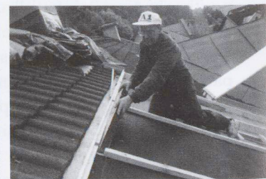
Montaggio di un pannello isolante
