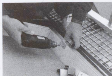
Montaggio dei supporti per il vetro
