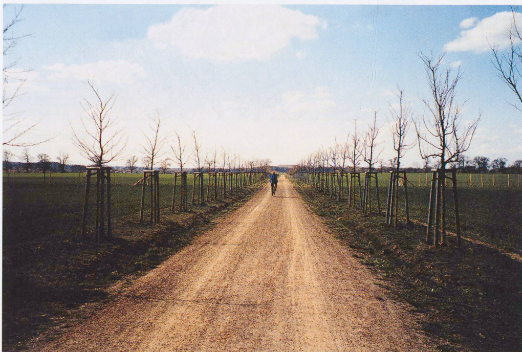
Ricostruzione della Grenz-Allee con nuovi fossi laterali (non progettati né previsti da Lenné) e filari di gelsi che creano una separazione tra la strada e i campi coltivati. Chiamata Morus Alba o Maulbeer-Allee (letteralmente «Viale dei Gelsi»), questa spettacolare strada interpodereale attraversa da est a ovest, centralmente e longitudinalmente la Bornimer Feldflur evidenziandone l'orografia e termina a ovest della collina morenica Grosseheineberg (oggi ancora grande discarica)
