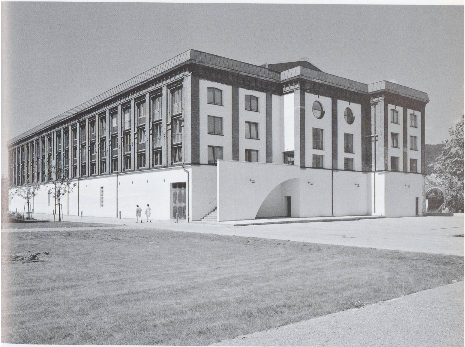
Vista dopo la trasformazione
