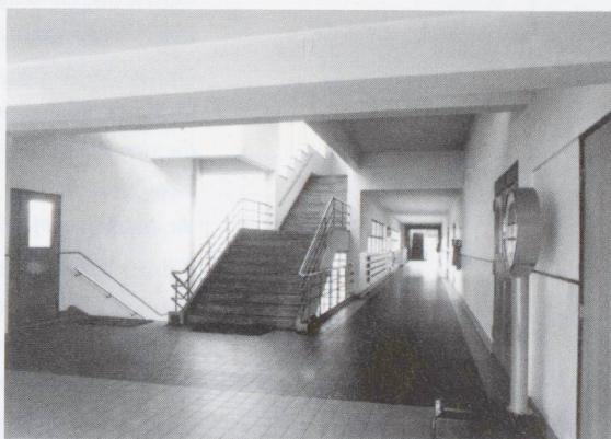
Vano scala principale, primo piano, circa 1930. Sono visibili, tra gli altri: il blocco delle toilette «fluttuante» e le superfici di mattoni in vetrocemento. Le piastrelle sono marroni e gialle e la porta dell'aula è dipinta di blu. Foto HTV
