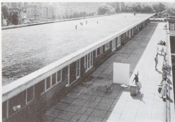
La terrazza prima del restauro
