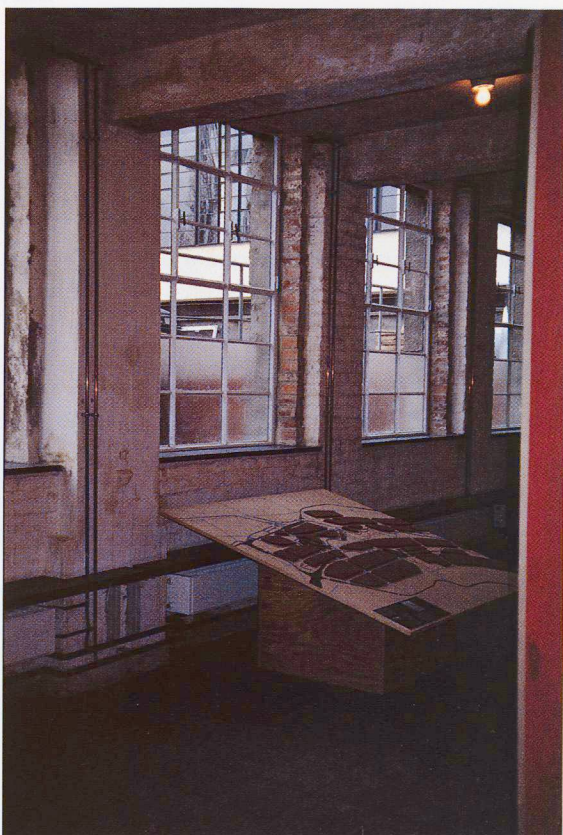
Dettaglio della cantina
