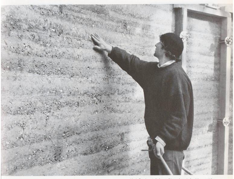
Martin Rauch controlla il muro di terra, che resterà a vista senza intonaco od altre protezioni. Nella texture del muro è possibile riconoscere i frammenti delle macerie dell'antica chiesa abbattuta durante la guerra fredda
