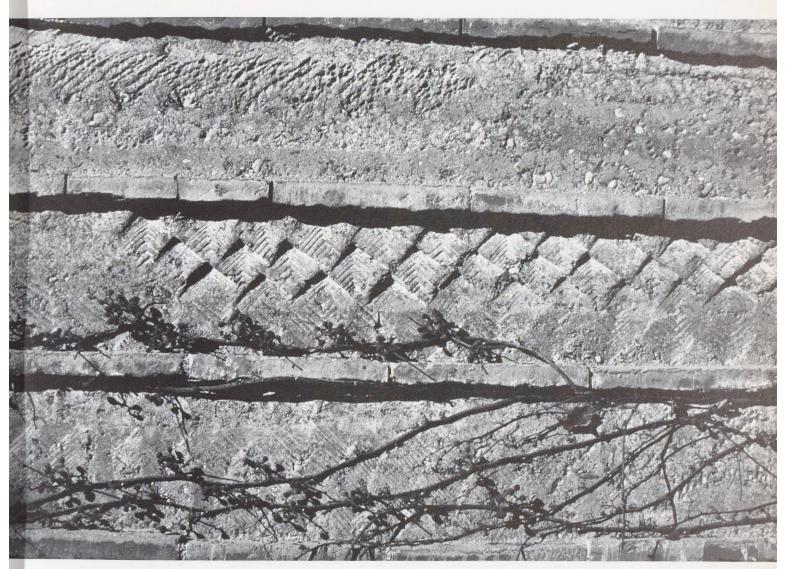
L'uso di terre diverse e il rafforzamento del muro umido con compattatori speciali caratterizza tutti i lavori di Martin Rauch. Le pareti di terra a vista si arricchiscono di colori e texture che resistono anche alle intemperie, come nel caso di questa parete esterna dell'atelier Rauch a Schlins, Austria, realizzata nel 1985
