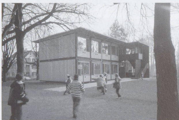
Scuola materna costruita con elementi modulari prefabbricati Zurigo-Gubel, scuola materna città di Zurigo, Bauart Architekten, Berna (foto Ruedi Walti)
