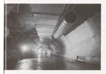
8 — Acceleratore da 57 kW disposto in calotta
