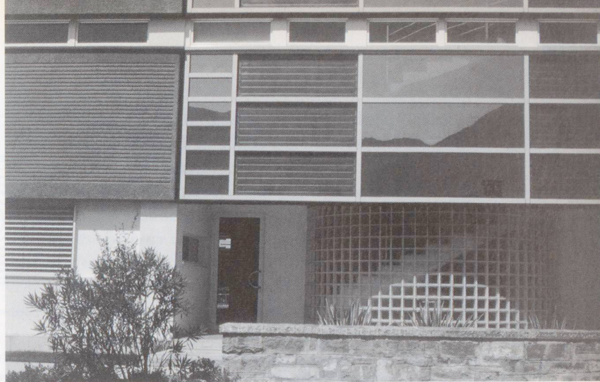
3 — Collettori solari per l'acqua calda sanitaria
